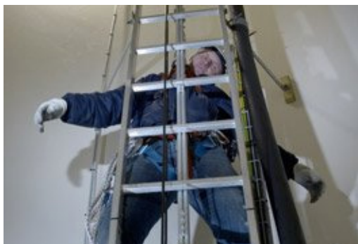
El sistema de protección anti-caída evita la caída del usuario, si le entra malestar o por accidente no pisa firme
